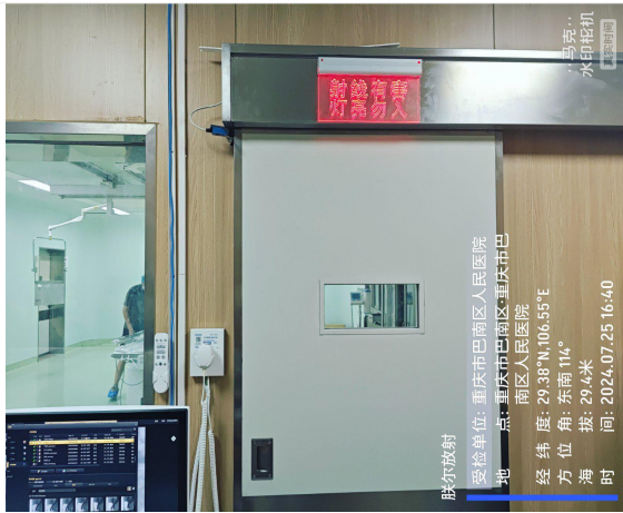
控制室警示标识、工作状态指示灯等
