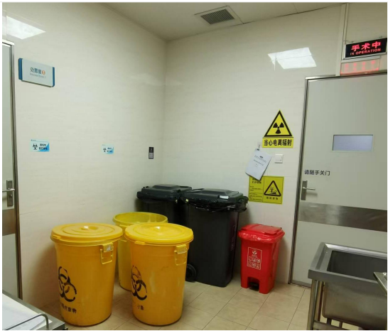
污物处置间防护门、工作状态指示灯、警示标识等
